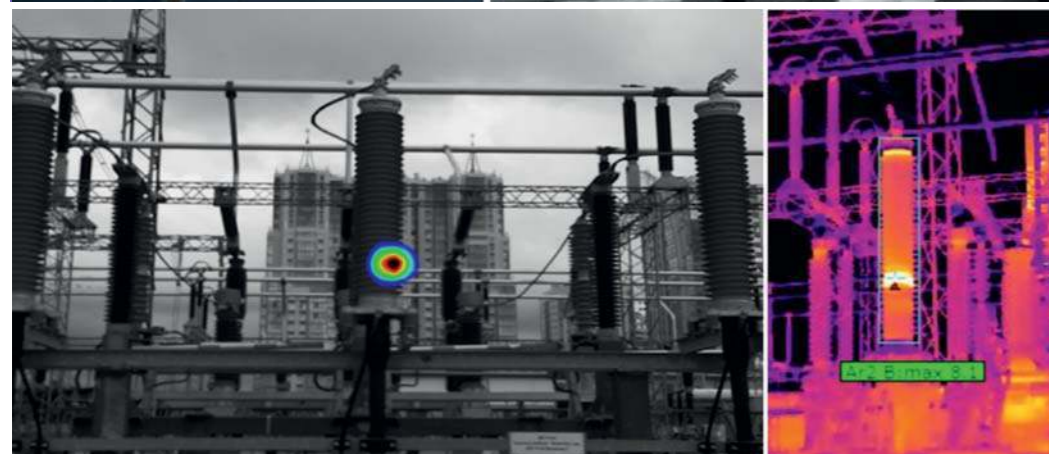
Рис. 4. Сравнение результатов инфракрасного и ультразвукового обследования муфт
